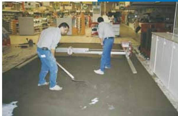
Mise en place et surfacage de la chape à la machine
